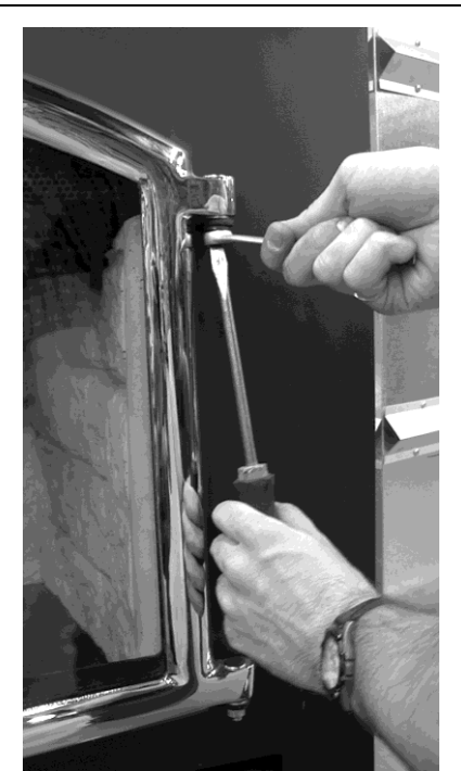
Figure 4 Ajustement des pentures de porte
