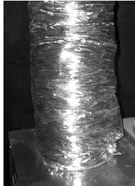
**Figure 3** Installation du tuyau flexible isolé par-dessus l'amarce
